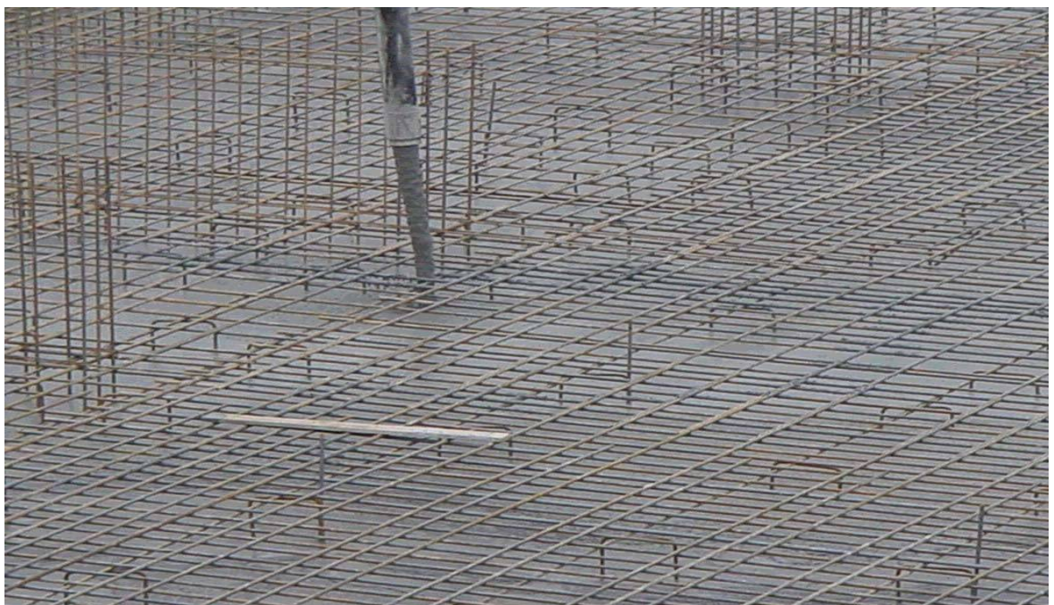
Obrázek 6: Betonování desky ze samozhutnitelného betonu. Komerční centrum, Ferrara, Itálie.
