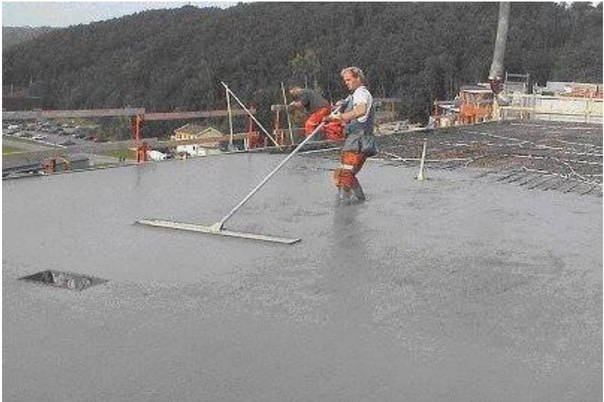
Obrázek 7: Vyrovnavání povrchu samozhutitelného betonu pomocí hladítka
