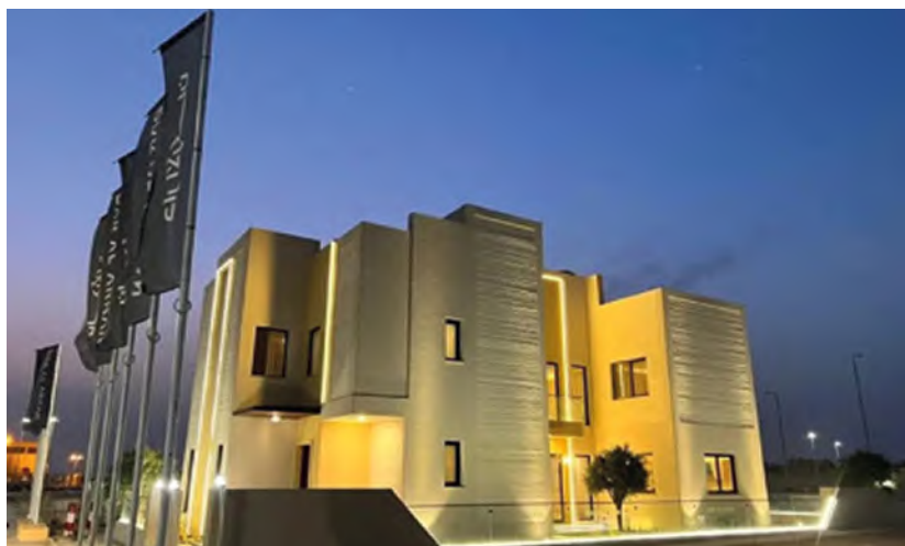
3 Dosud nejvyšší dům zhotovený pomocí 3D tisku v Saúdské Arábii (zdroj: Zawya) 3 So far the tallest 3D printed house in Saudi Arabia (source: Zawya)
