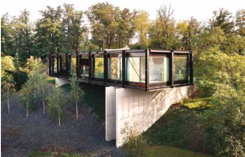
7 Vnější nosná část montované ocelové konstrukce, složená z profilů HEB 300, překlenuje osmnáctimetrový rozestup monolitických železobetonových pilířů 8 Schodiště
