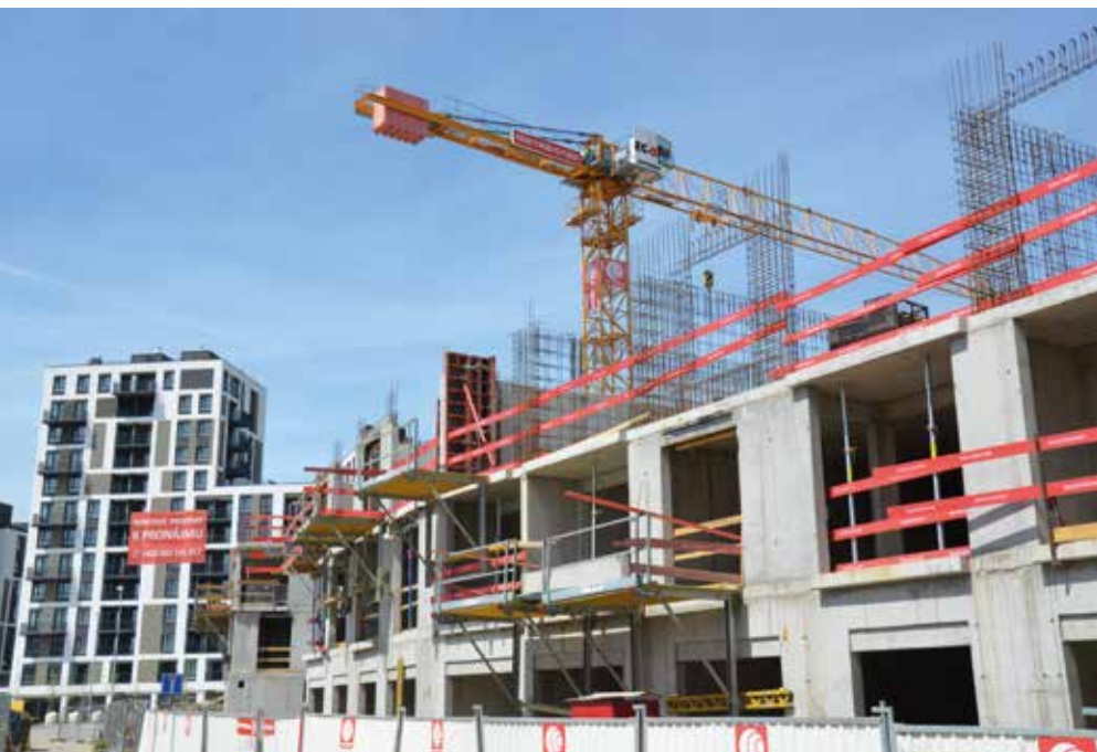
10 Realizace obytného souboru Vackov, kde byl využit beton s recyklovaným kamenivem R-CRETE® s 50% podílem recyklátu převážně na stěnové konstrukce
