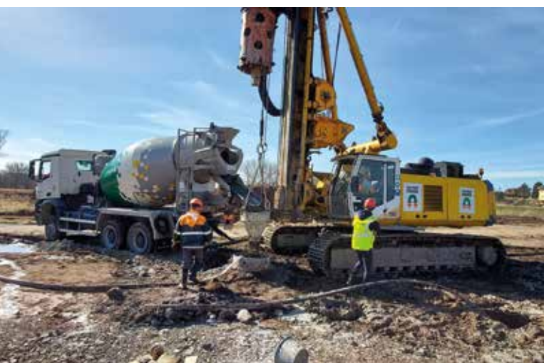
7 Realizace vrtaných pilot za využití betonu s recyklovaným kamenivem o 15% podílu 8 Betonáž podkladních betonů na projektu Nová Waltrovka za využití betonu s recyklovaným kamenivem R-CRETE® o 50% podílu
