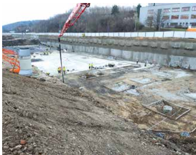
7 Realizace vrtaných pilot za využití betonu s recyklovaným kamenivem o 15% podílu 8 Betonáž podkladních betonů na projektu Nová Waltrovka za využití betonu s recyklovaným kamenivem R-CRETE® o 50% podílu
