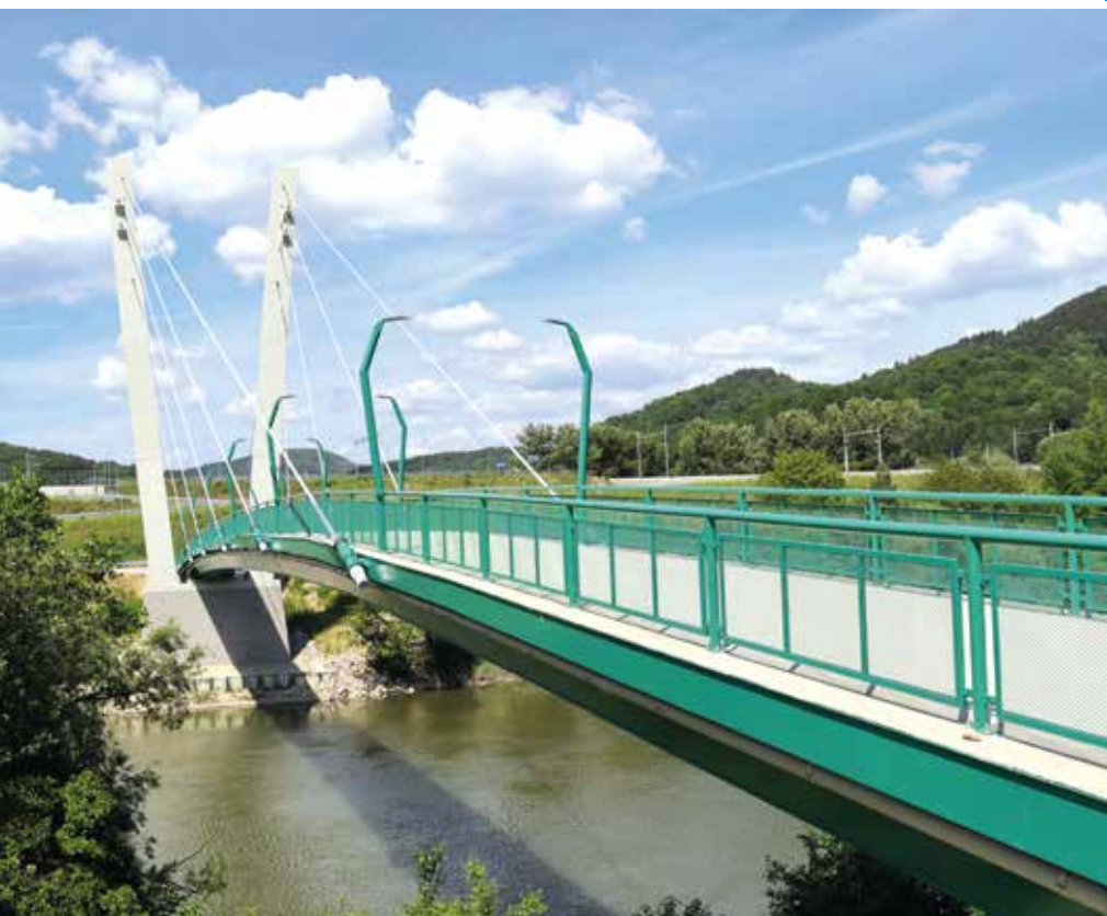
5 Cestný nadjazd nad železnicou po dokončení 6 Lávka nad Nosickým kanálom 5 Road overpass over the railway after its completion 6 New footbridge over the Nosice Canal
