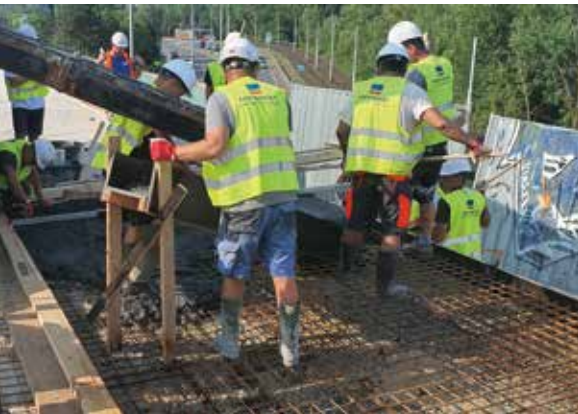
7 Ukládání UHPC přímo z automodchávače 8 Náštrik a zakrytí povrchu vrstvy UHPC 7 UHPC levelling directly from concrete mixer truck 8 Spraying and covering the surface of the UHPC layer
