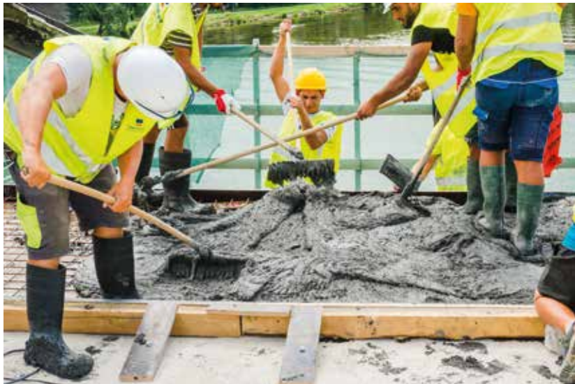
7 Ukládání UHPC přímo z automodchávače 8 Náštrik a zakrytí povrchu vrstvy UHPC 7 UHPC levelling directly from concrete mixer truck 8 Spraying and covering the surface of the UHPC layer
