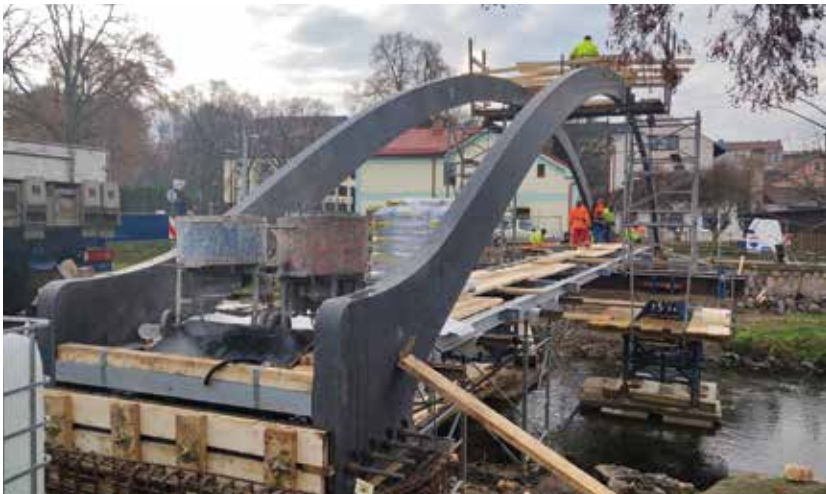
6 Prefabrikáty oblouků ve stojanech ve výrobě 7 Předmontáž mostovky 8 Pohled na osazenou nosnou část mostovky 9 Příprava na zmonolitnění 10 Stav lávky po betonáži monolitických částí z UHPC 6 Prefabricated arches at the manufacturing plant 7 Pre-assembly of the bridge deck 8 View of the installed load-bearing part of the bridge deck 9 The structure getting ready for the placement of in-situ infills using fresh UHPC 10 Condition of the bridge after concreting the site-cast parts of the UHPC
