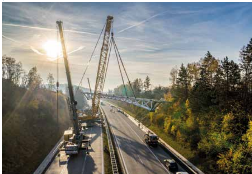
1 Jednopolový integrální most o rozpětí 59 m 2 Ocelobetonová nosná konstrukce nadjezdu: a) příčný řez, b) podélný řez 3 Schéma zhotovení opěry 4 Transport ocelové konstrukce 5 Osazení ocelové konstrukce
