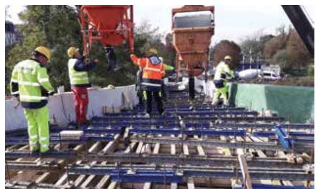
5 Charakteristický příčný řez a simulovaná část 6 Pohled do rozpletu před zaklopením 7 Betonáž rozpletu 8 Pole teplot, deformace a trhliny: a) v čase 14 h, b) v čase 672 h 9 Průběh teplot během chlazení rozpletu 10 Zvýrazněné trhliny na spojení rozpletu s parapetem 5 A typical cross-section of the footbridge and the part which was simulated (in red) 6 View of the junction (Štvanice branch) before being covered 7 Concreting of the junction 8 Temperature field, deformation and cracks at the age of: a) 14 h, b) 672 h 9 Temperatures recorded during the cooling of the concrete at the footbridge junction 10 Heightened (in red) cracks occurring at the connection between the in-situ deck and the prefabricated upright parapet
