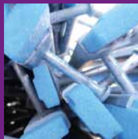
Bořislavka Kotvení fasády
