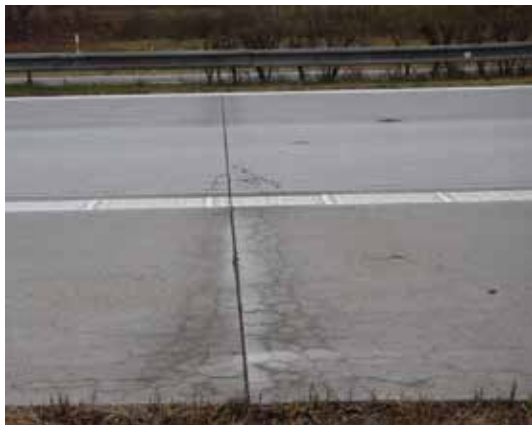
1 Příklad vzniku trhlin na dálnici D1 km 237,4; stáří krytu 17 let 2 Povrchové trhliny CBK s ohledem na jejich stáří
