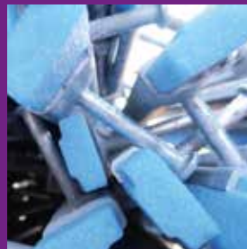
Bořislavka Kotvení fasády
