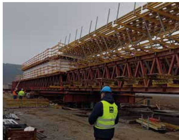
1 Pohled na celou estakádu (SO 1202 úseky A, B a C) 2 Vzorový příčný řez (úsek A a B) 3 Podélný řez: a) úsek A, b) úsek B 4 Posuvná skruž pro úsek A a B 5 Běžný tvar pilířů 6 Přechod mezi tvarem NK úseku B a C na pilíři 33
