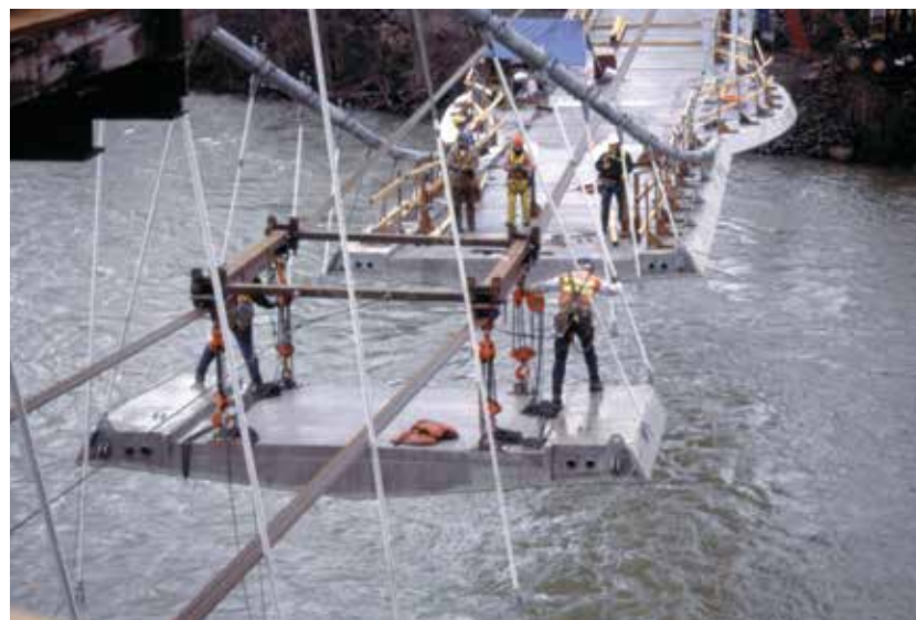
1 Do podloží kotvená visutá konstrukce: a) montáž, b) provoz 2 Samokotvená visutá konstrukce: a) montáž, b) provoz 3 Lávka přes řeku Willamette, Eugene, Oregon, USA – montáž segmentů 4 Lávka Pforzheim I, Německo 5 Lávka Pforzheim I, Německo: a) příčný řez mostovkou, b) příčný řez lávkou, c) podélný řez, d) půdorys 1 Earth anchored suspension structure: a) erection, b) service 2 Self-anchored suspension structure: a) erection, b) service 3 Willamette River Pedestrian Bridge, Eugene, Oregon, USA: erection of the segments 4 Pforzheim I Footbridge, Germany 5 Pforzheim I Footbridge, Germany: a) cross-section of the deck, b) cross-section of the footbridge, c) longitudinal section, d) plan
