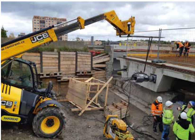
9 Předpínání mostu 9 Prestressing of the bridge
