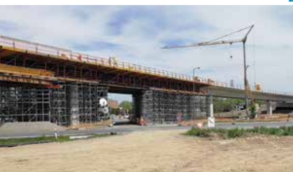
1 Betonáž mostovky s použitím přísady slump keeper 2 Most na obchvatu Krnova
