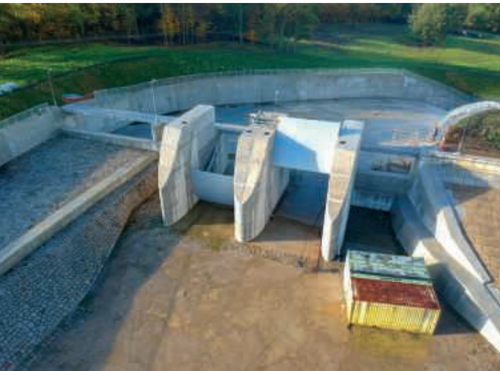
4 Schéma bednění přelivné plochy 5 Výstavba pilířů přelivného objektu 6 Nové segmentové hrazení přelivu 7 Proudová výstavba levobřežní stěny 8 Stavba levobřežní stěny skluzu 9 Betonáž líce pravobřežní stěny 10 Povodňový průtok v průběhu prací 11 Betonáž dna skluzu 12 Letecký snímek staveniště 4 Scheme of spillway nappe formwork 5 Construction of the spillway piles 6 Radial gates of the new spillway 7 Job stream on the left bank wall 8 Chute left bank wall construction 9 Right bank wall face concreting 10 Flood runoff during the proceeding works 11 Chute bottom concreting 12 Aerial photograph of the site
