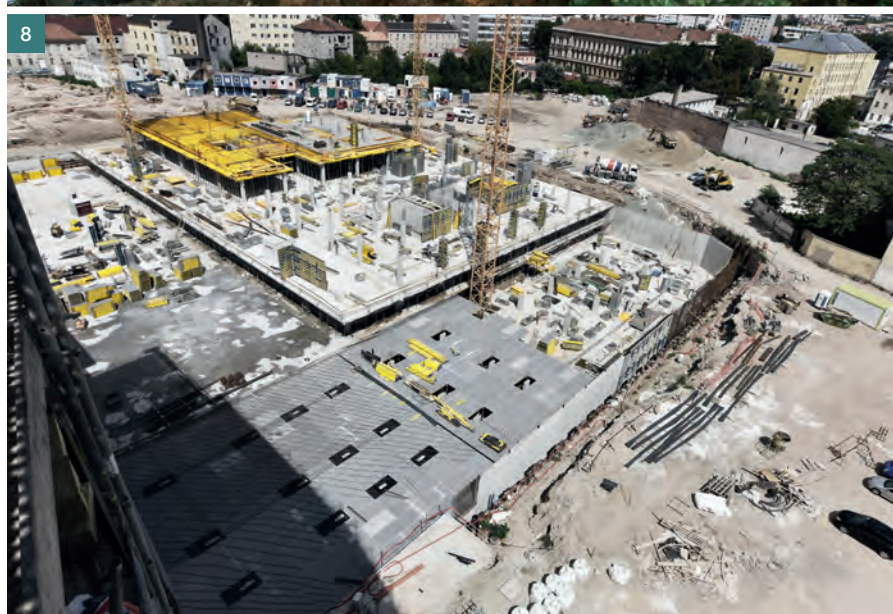
5 Rekonstrukce dálničního mostu přes jezero Petersdorfer 6 Výstavba silničního mostu Seckachtal 7 Domov seniorů v Mnichově 8 Komplex administrativních budov Vlněna v Brně 5 Reconstruction of the motorway bridge over the Petersdorfer lake 6 Construction of the Seckachtal road bridge 7 Retirement home in Munich 8 Office building complex Vlněna in Brno
