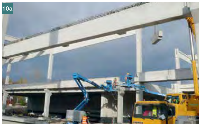
6 Montáž stĺpov skeletu na oporný múr 7 Rubová strana oporného múra 8 Prekládka kanalizácie 9 Podchytenie základov verejného osvetlenia na výpadovke do Brezna 10 a), b) Montáž prefabrikovaného skeletu 11 a), b), c) Komplikované tvary krátkych konzol ■ 6 Installation of columns onto the retaining wall 7 Back side view of the retaining wall 8 Relocated sewer system 9 Underpinned streetlight foundation 10 a), b) Installation of the precast concrete frame 11 a), b), c) Complex shapes of precast column corbels
