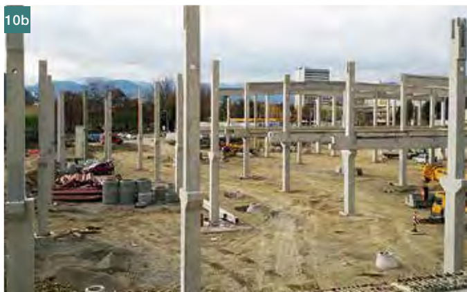
6 Montáž stĺpov skeletu na oporný múr 7 Rubová strana oporného múra 8 Prekládka kanalizácie 9 Podchytenie základov verejného osvetlenia na výpadovke do Brezna 10 a), b) Montáž prefabrikovaného skeletu 11 a), b), c) Komplikované tvary krátkych konzol ■ 6 Installation of columns onto the retaining wall 7 Back side view of the retaining wall 8 Relocated sewer system 9 Underpinned streetlight foundation 10 a), b) Installation of the precast concrete frame 11 a), b), c) Complex shapes of precast column corbels
