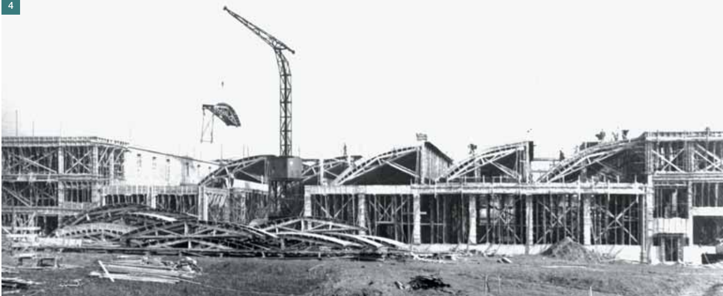
Obr. 4 Montáž bednění pro systém Zeiss-Dywidag pro továrnu firmy Feinapparate-Bau v Teplicích-Trnovanech, 1940 ■
