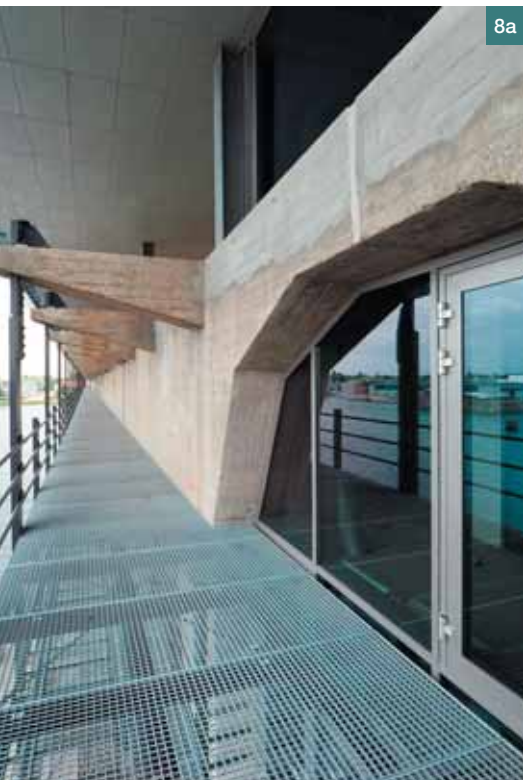
Obr. 8a,b,c Jednota betonového kolosu bývalé jeřábové dráhy a nové ocelové nástavby ■ Fig. 8a,b,c Former concrete crane way and the new steel building in harmony
