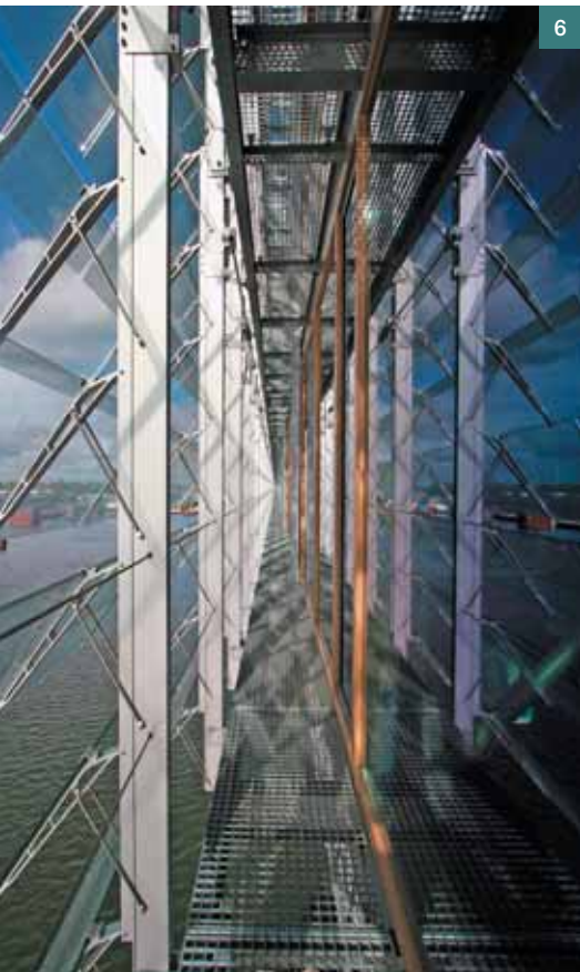
Obr. 6 Mezi vnější a vnitřní fasádou ■ Fig. 6 Between the double-skin facade
