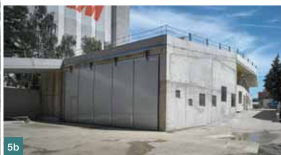
Obr. 5 a) Celkový pohled, b) fasáda s desetimetrovými vyklápěcími vraty sloužícími jako zastřešení, c) vjezd na parkoviště na střeše, d) pohled na střechu ■ Fig. 5 a) Overall view, b) facade with 10-meter-wide tipping gate which serves also as a roof, c) entrance to the parking lot on the roof, d) view to the roof
