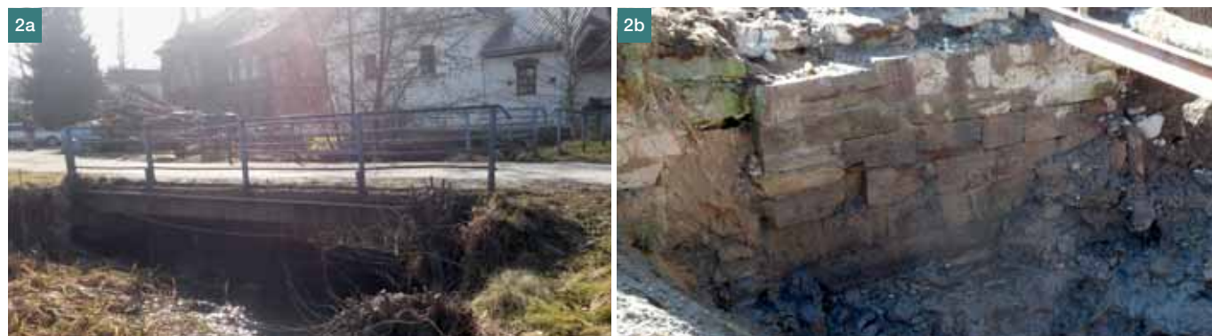
Obr. 2 Původní konstrukce mostu SZ-001 Na Káčku: a) boční pohled na most, b) opěrná zeď po odstranění mostu ■ Fig. 2 Original structure of SZ-001 Na Káčku bridge: a) lateral view of the bridge, b) abutment after removal of the bridge
