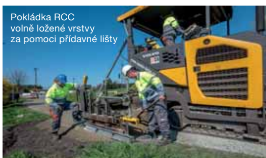
Pokládka RCC do silničního obrubníku
