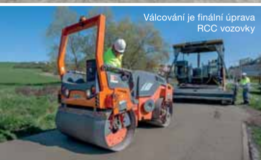
Pokládka RCC do silničního obrubníku
