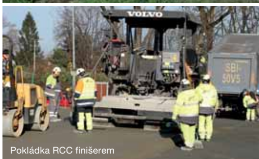
Válcování je finální úprava RCC vozovky
