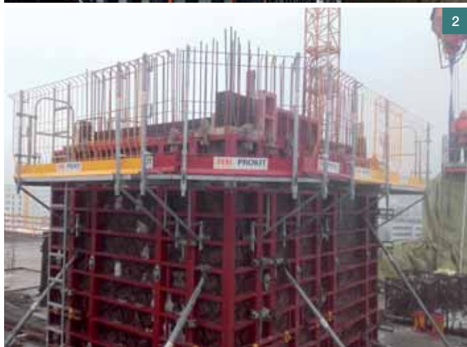
Obr. 1 Příslušenství pro zajištění bezpečnosti na menších monolitických stavbách – betonářské konzoly a držáky se sloupky zábradlí: a) bezpečný pohyb pracovníků při betonáži monolitických stěn do lehkého univerzálního ručního bednění, b) zajištění volného okraje před armováním a následnou betonáží stropu do stejného bednění
