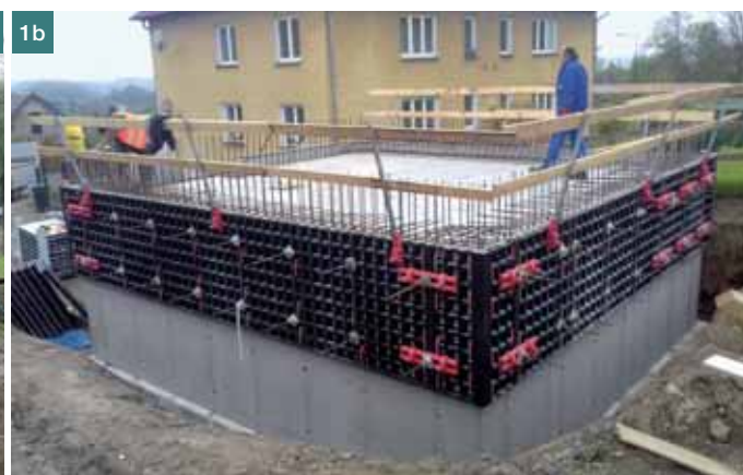
Obr. 1 Příslušenství pro zajištění bezpečnosti na menších monolitických stavbách – betonářské konzoly a držáky se sloupky zábradlí: a) bezpečný pohyb pracovníků při betonáži monolitických stěn do lehkého univerzálního ručního bednění, b) zajištění volného okraje před armováním a následnou betonáží stropu do stejného bednění
