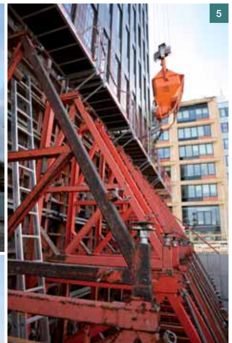
Obr. 6 Zajištění volného okraje vodorovných konstrukcí: a) zajištění již zabetonované konstrukce systémovými prvky stejně jako zajištění okraje na bedněném stropě, b) systémové prvky na volném okraji konstrukce
