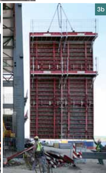
Obr. 3 Řešení pro vysoké monolitické stěny: a) armovací lešení a systémové bednění s předem osazenými podlahami a zábradlí, b) bednění při přesunu – modulové podlahy a zábradlí jsou ve stejných šířkách jako bednicí panely, a tudíž není nutné při přesunu ze záběru do záběru podlahy a zábradlí demontovat, c) kompletní bednicí sada s veškerými bezpečnostními prvky – systémové podlahy, integrované žebříky v podlahách s průřezem, to vše na jednostranně obsluhovaném bednění
