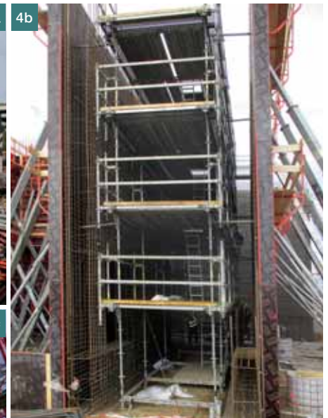
Obr. 5 Systémové podlahy pro betonáž stěny bedněné jednostranně
