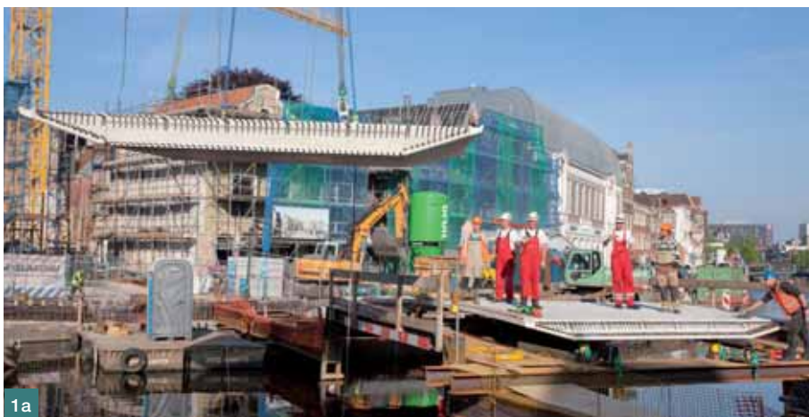
Obr. 1 Most Catharinabridge v Leidenu: a) ukládání segmentů mostovky, b) osazování segmentů opěr s přečnívající výztuží, c) po dokončení ■ Fig. 1 UHPC Catharinabridge in Leiden: a) installation of the deck slab segments, b) protruding reinforcement fitting together, c) after completing (photo: a,c – Gerda van Ekris, b – Buro JP)
