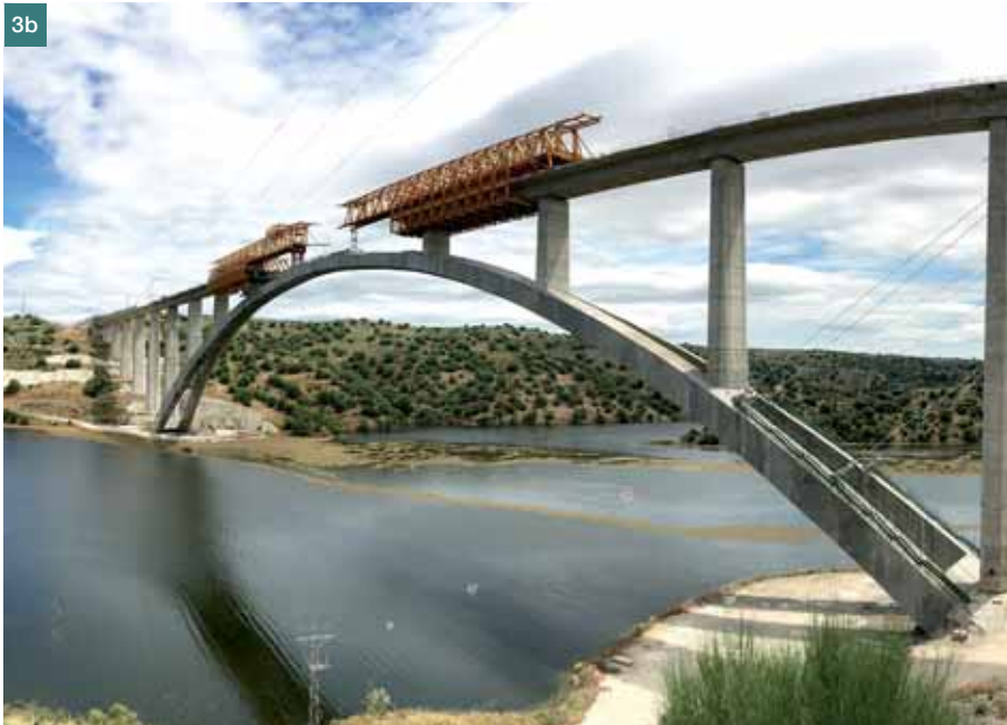
Obr. 3 Viadukt Almonte River: a,b) výstavba, c) po dokončení hrubé stavby ■ Fig. 3 Almonte River Viaduct: a,b) under construction, c) after finishing the superstructure (photo: a,c – FCC Construcción, b – Arenas & Asociados)
