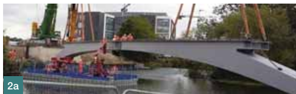
Obr. 2 University Bridge v Northamptonu: a) montáž nosníku, b) po dokončení Fig. 2 University Bridge in Northampton: a) steel arch installation, b) after completing
