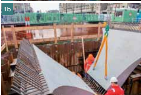
Obr. 1 Most Catharinabridge v Leidenu: a) ukládání segmentů mostovky, b) osazování segmentů opěr s přečnívající výztuží, c) po dokončení ■ Fig. 1 UHPC Catharinabridge in Leiden: a) installation of the deck slab segments, b) protruding reinforcement fitting together, c) after completing (photo: a,c – Gerda van Ekris, b – Buro JP)
