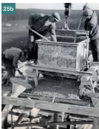
Obr. 27 Nanášení cementové (betonové) vrstvy na izolaci vyztužené drátěným pletivem ■ Fig. 27 Applying cement (concrete) layer onto the insulation reinforced by a wire mesh
