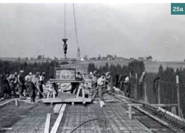
Obr. 25a,b,c Betonování mostovky nad velkou klenbou ■ Fig. 25a,b,c Concreting the bridge slab above the main arch
