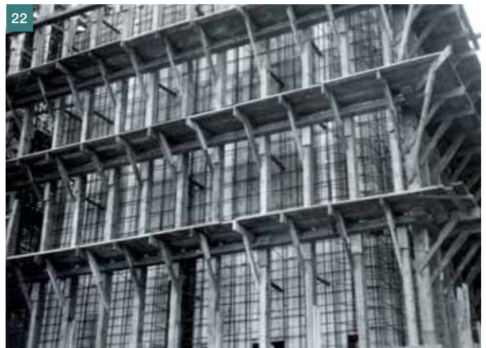
Obr. 24 Šalování mostovky nad 6. klenbou ■ Fig. 24 Formworking of the bridge slab above arch no. 6
