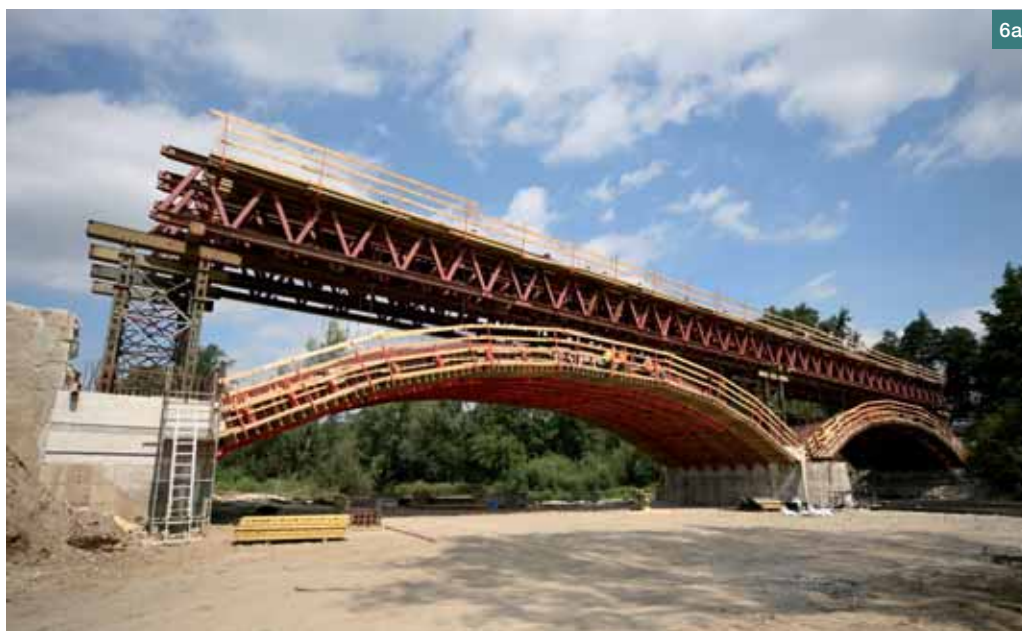
Obr. 6 Vyvěšené bednění pro budoucí mostovku: a) celkový pohled na bedněnou konstrukci mostu u Zátaví a způsob zavěšení, b) bednění opěrných stěn, c) pohled zespodu
