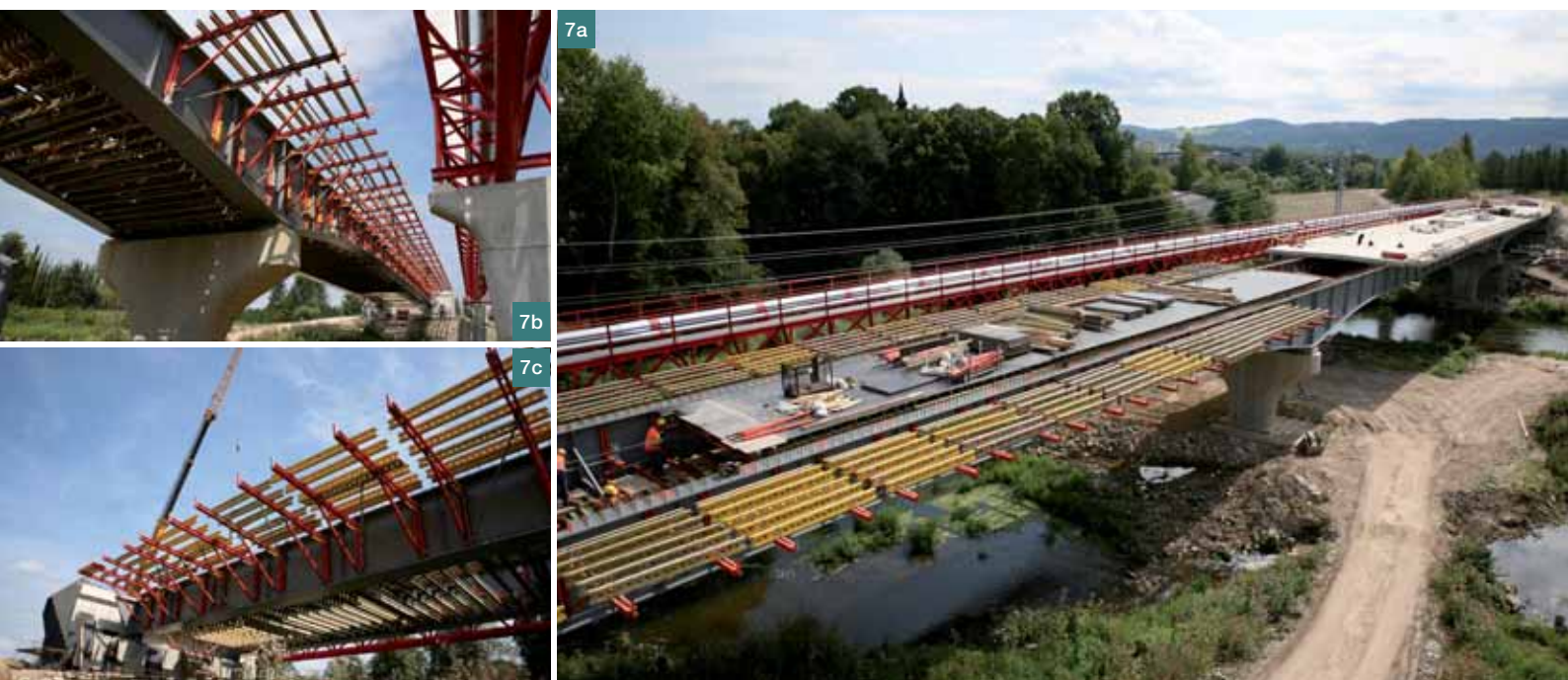
Obr. 7 Spřažená ocelobetonová konstrukce s proměnnou výškou ocelových nosníků: a) celkový pohled na most u Sokolova, b,c) zavěšené konzoly pro betonáž mostovky
