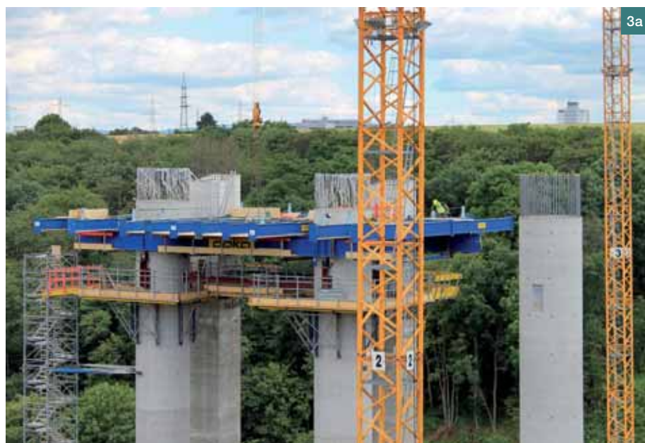
Obr. 3 a) Pracovní plošina v hlavách pilířů, b) podhled plošiny (nosné pilíře mají kruhový průřez, sekundární pilíře čtvercového průřezu zajišťují stabilizaci v průběhu výstavby) ■ Fig. 3 a) Working platforms in the heads of the piers, b) soffit of the platform (load bearing piers are of circular cross section, secondary piers of rectangular section ensure stabilization during the construction)
