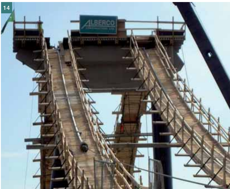
Obr. 7 Visutý kabel a typický závěs
