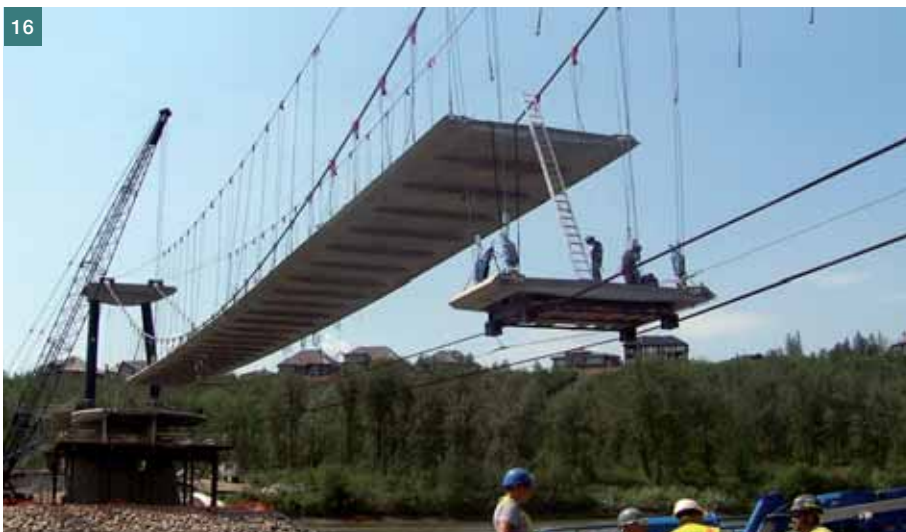
Obr. 16 Montáž segmentu
