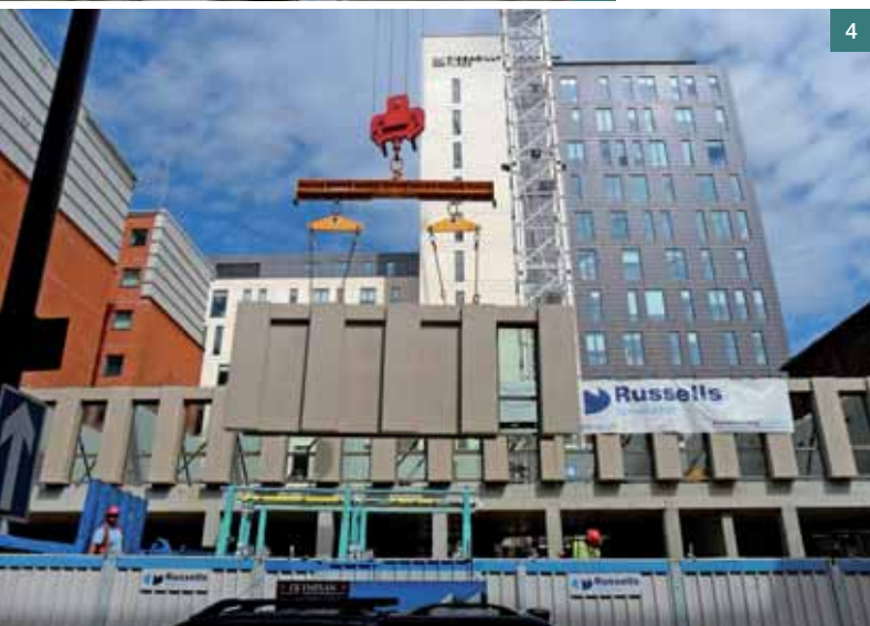
Obr. 5 Modulová konstrukce ■ Fig. 5 Modular construction
