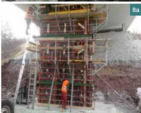
Obr. 7 a) Zabetonovaná konstrukce pro zesílení stávajícího pilíře, b) výsledný povrch betonu zesíleného pilíře s otiskem rámového bednění včetně plnicího ventilu
