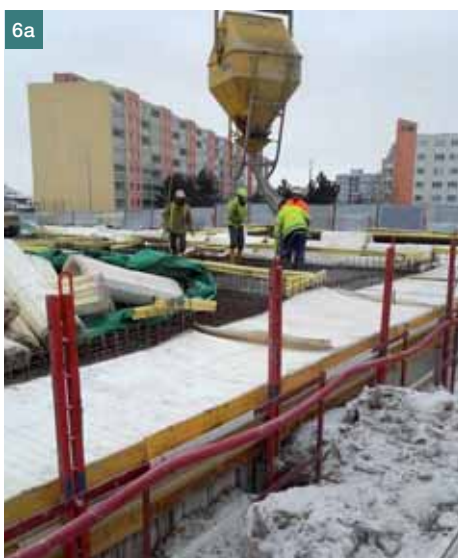
Obr. 4 Provizorní zastřešení před betonáží části základové desky ■ Fig. 4 Makeshift roofing before concreting part of the base slab
