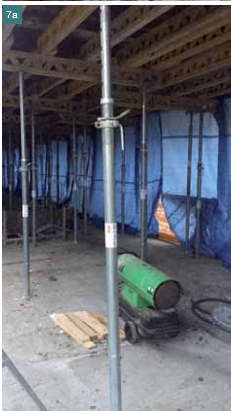
Obr. 7 a) Vyhřívání prostoru pod stropní konstrukcí, b) zaplachtování prostoru pod bedněným stropem ■ Fig. 7 a) Heating the space below the slab construction structure, b) covering of the space under the slab construction with formwork
