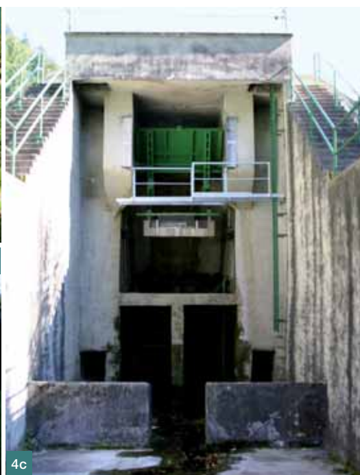
Obr. 4 Nádrž Jelenec: a) za hydroelektrárnou Dolní Jelenec, b) stavidlo a konstrukce hráze, c) stavidlo, d) stavidlo přivaděče na Staré Hory Fig. 4 The Jelenec reservoir: a) view from the hydroelectric power station Dolní Jelenec, b) sluice-gate and the dam mass, c) sluice-gate, d) sluice-gate of penstock to Staré hory
