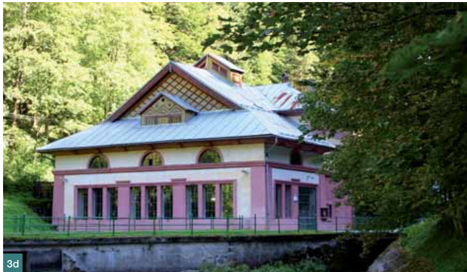
Obr. 3 Hydroelektrárna Dolní Jelenec: a) ve výstavbě, bednění a betonování základů s pozicemi pro turbíny, b) dokončování krovu a v popředí ještě původní zástavba, která musela ustoupit nádrži Jelenec, c) přírodní ocelové roury připraveny k napojení, výtokový bazén dobetonován, d) pohled od nádrže Jelenec, e) detail kazetového stropu s osvětlením, f) strojovna s turbínami ■ Fig. 3 Hydroelectric power station Dolní Jelenec: a) under construction, formwork and concreting of the foundations for turbines, b) completion of rafters and former settlement in position of the Jelenec reservoir, c) steel penstock prepared to be linked up, the outlet basin finally concreted, d) view from the Jelenec reservoir, e) detail of the coffered ceiling with light, f) turbine hall
