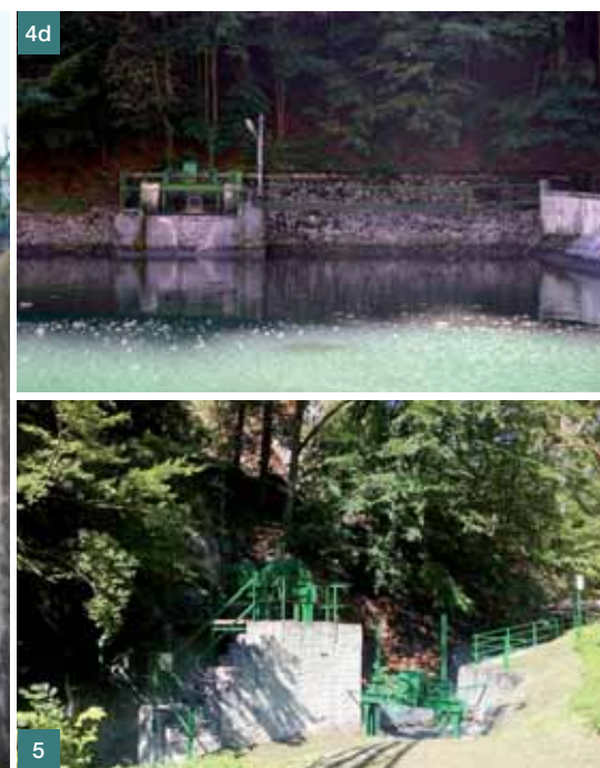
Obr. 4 Nádrž Jelenec: a) za hydroelektrárnou Dolní Jelenec, b) stavidlo a konstrukce hráze, c) stavidlo, d) stavidlo přivaděče na Staré Hory Fig. 4 The Jelenec reservoir: a) view from the hydroelectric power station Dolní Jelenec, b) sluice-gate and the dam mass, c) sluice-gate, d) sluice-gate of penstock to Staré hory
