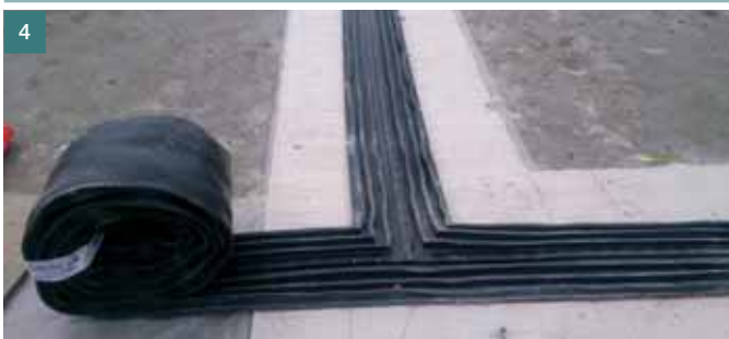
Obr. 4 Příklad realizace – pokládka vnějšího těsnicího dilatačního pásu na podkladní beton Fig. 4 Example of construction – installation of external expansion sealing tape on blinding concrete
