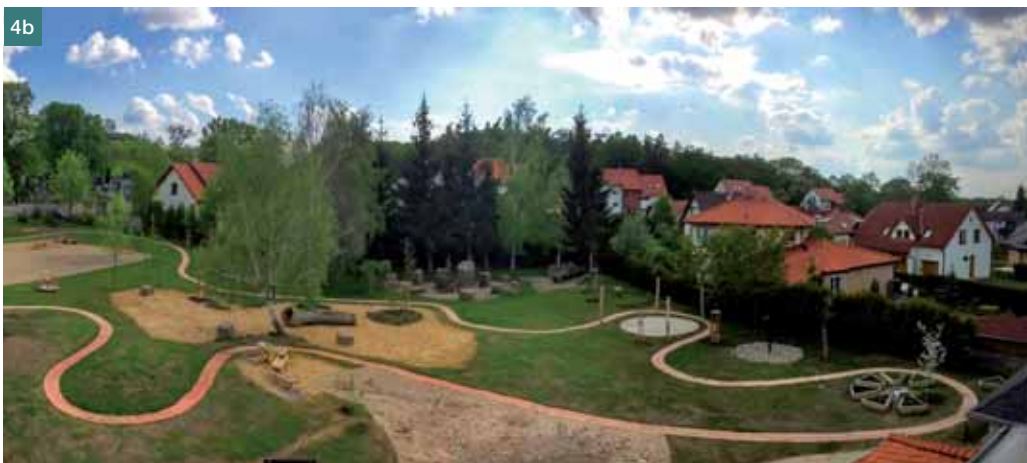
Obr. 4a,b Chodníček z červeného betonu, dávka pigmentu 3 % (ZŠ a MŠ Koloděje) ■ Fig. 4a,b Pathway from red concrete, pigment dose 3 % (Elementary school and Kindergarten in Koloděje)
