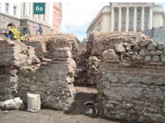
Obr. 6 Výstavba: a,b) hloubení stavební jámy, vykopávky a hledání míst pro podpěrné konstrukce, c) umístění bednění a protahování výztuže ve stísněném prostoru ■ Fig. 6 Construction: a,b) excavating the construction pit, excavations and searching for locations of the supporting structures, c) placing the formwork and running the reinforcement in the straitened space
