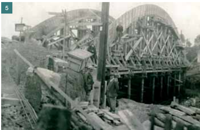
Obr. 5 Stavba mostu přes Lužickou Nisu v Chotyni v roce 1932, dobová pohlednice ■ Fig. 5 Construction of the bridge over the Lužická Nisa river in Chotyně 1932, period postcard
