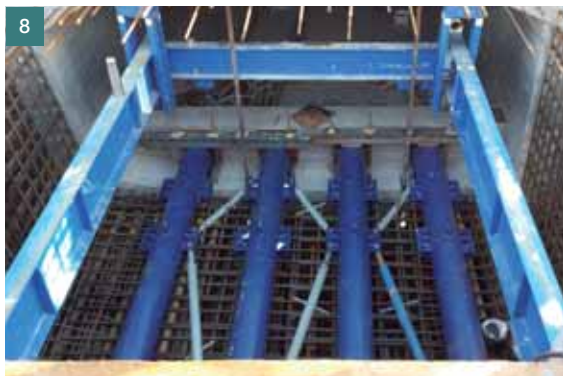
Obr. 8 Rozpínání vahadel ■ Fig. 8 Bracing of the cantilevers
