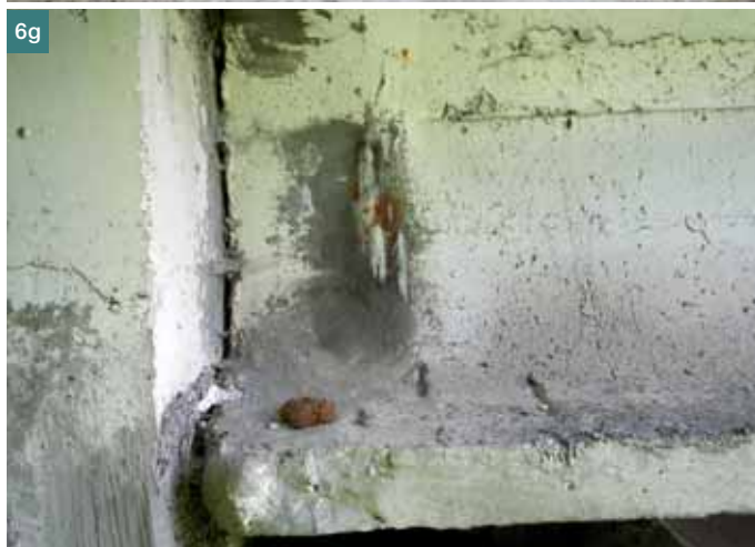
Obr. 6a až h – Nefunkční nátěrový systém na podhledu prefabrikovaných nosníků ■ Fig. 6 a to h Nonfunctional coating system on the soffit of the precast beams
