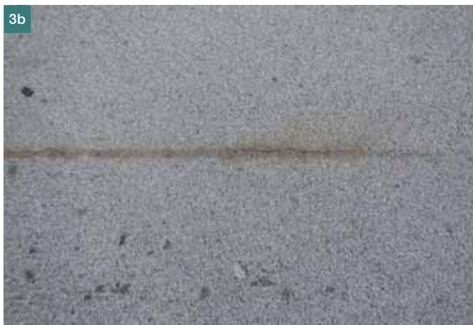
Obr. 3a až d Koroze výztuže horní části nosníku pod vozovkovým souvrstvím ■ Fig. 3a to d Corrosion of the reinforcement of the upper part of the beam under the road way formation
