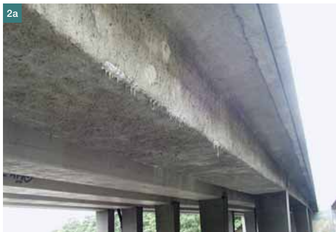
Obr. 2a,b Porucha povrchu – chybný návrh hmoty pro opravu a technologie provedení ■ Fig 2a,b Failure in the surface – improper design of the substance for repairs and incorrect technology
