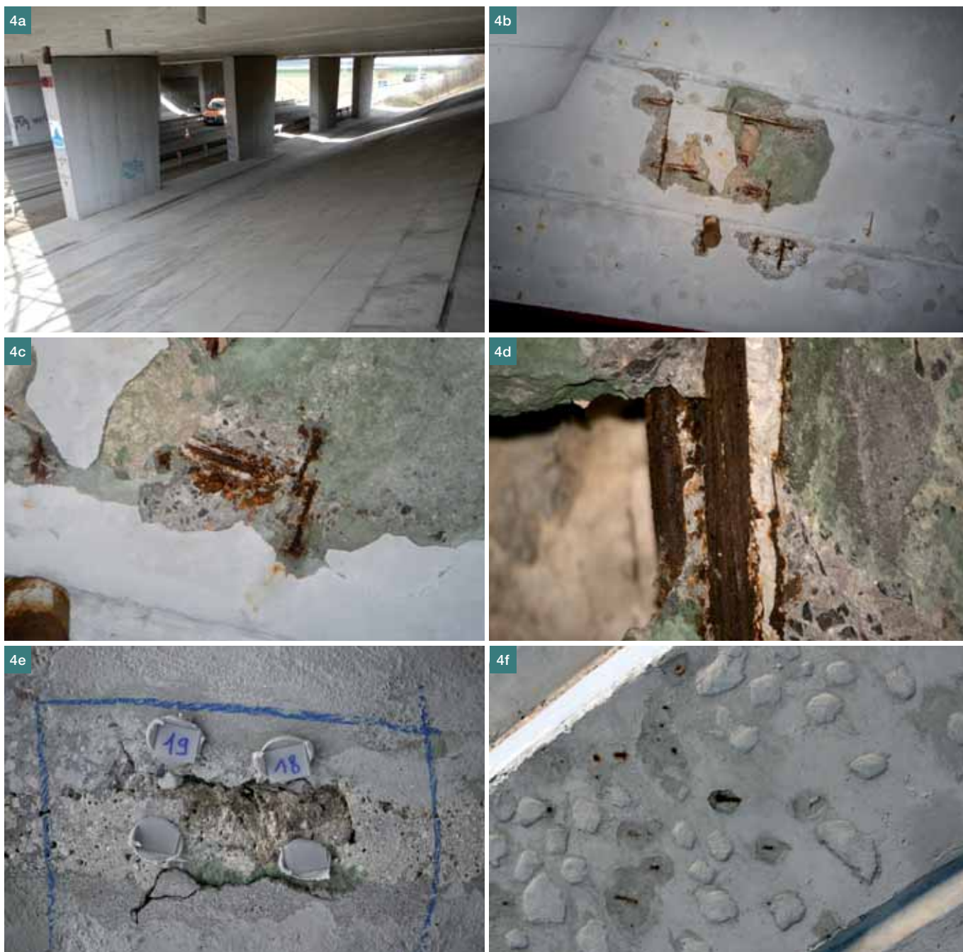
Obr. 4a až f Separace povlakových a reprofilačních vrstev systémů oprav od betonových povrchů ■ Fig. 4a to f Separation of the coat and repair layers of the repair system from the concrete surfaces
