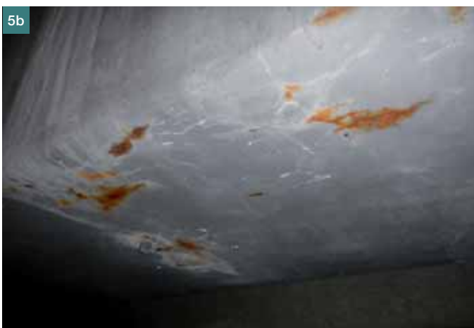
Obr. 5a až f – Separace povlakových a reprofilačních vrstev systémů oprav od betonových povrchů a trhliny na hranách vlivem tlaku koroze – selhání celého sanačního systému ■ Fig. 5a to f – Separation of the coat and repair layers of the repair system from the concrete surfaces and cracks on the edges caused by the corrosion pressure – failure of the repair system as a whole
