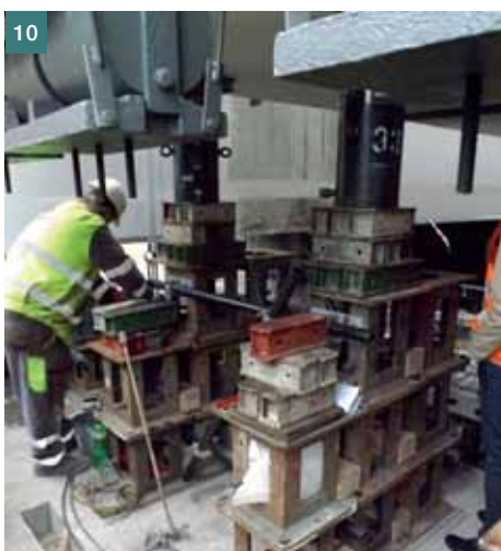
Obr. 10 Manipulace s KT nosníky – II. etapa
