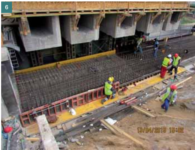
Obr. 4 Práce na úložném prahu pod zvednutými nosníky – I. etapa Fig. 4 Works on the footing sill under the lifted girders – phase I
