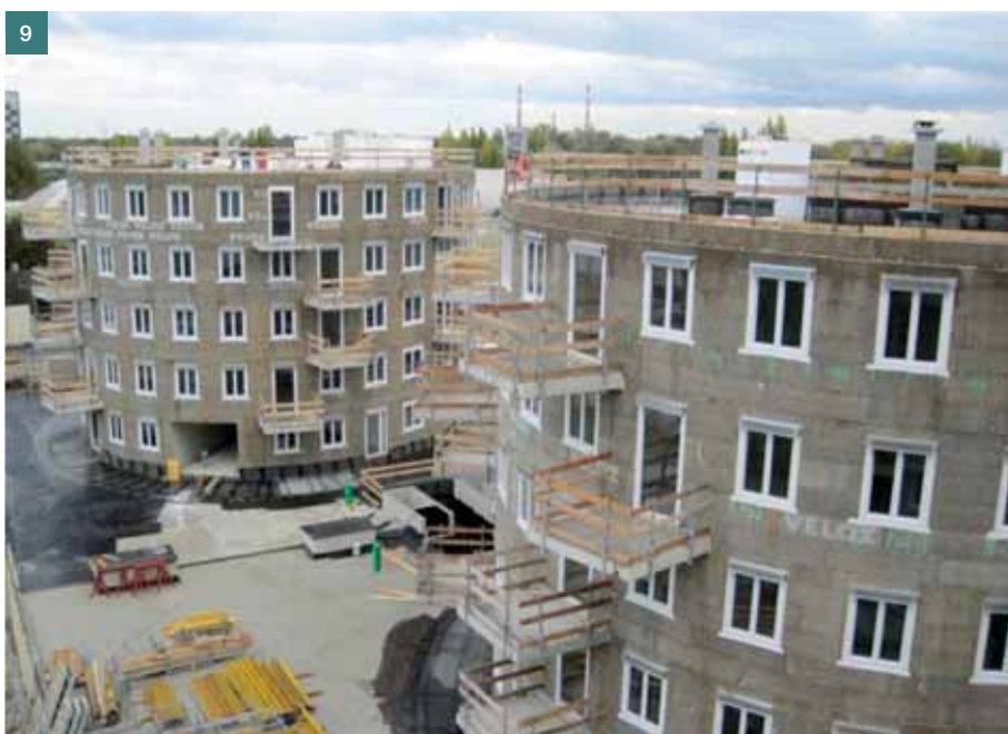
Obr. 9 Budovy kruhového průřezu s visutými balkóny na konzolách ■ Fig. 9 Buildings of circular section with hanging balconies on braces
