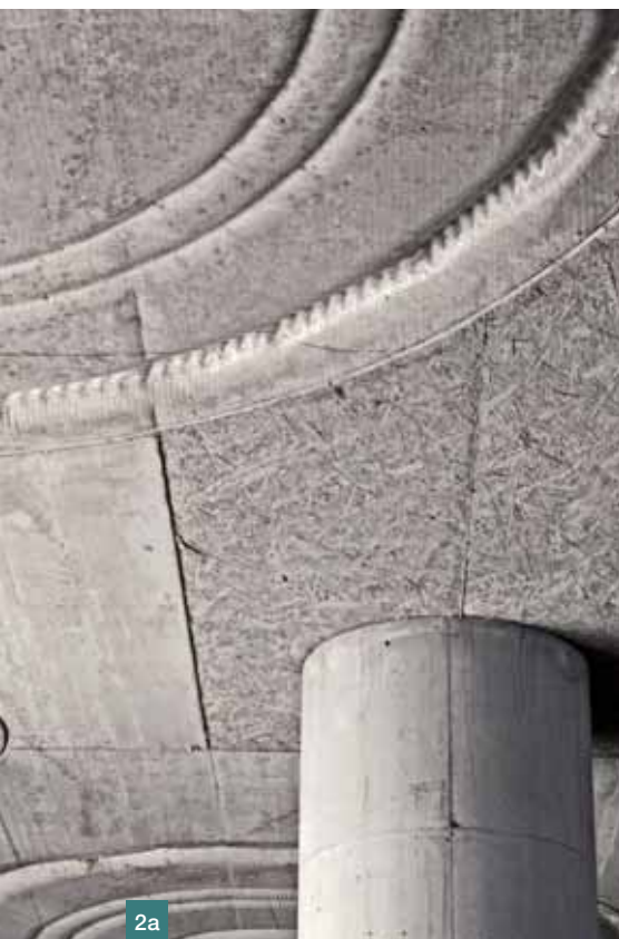
Obr. 2a,b Na stropěch je možné najít i kruhové otisky tvořené lany a kabely ■ Fig. 2a,b Circular prints of ropes and cables can be found on the ceilings
