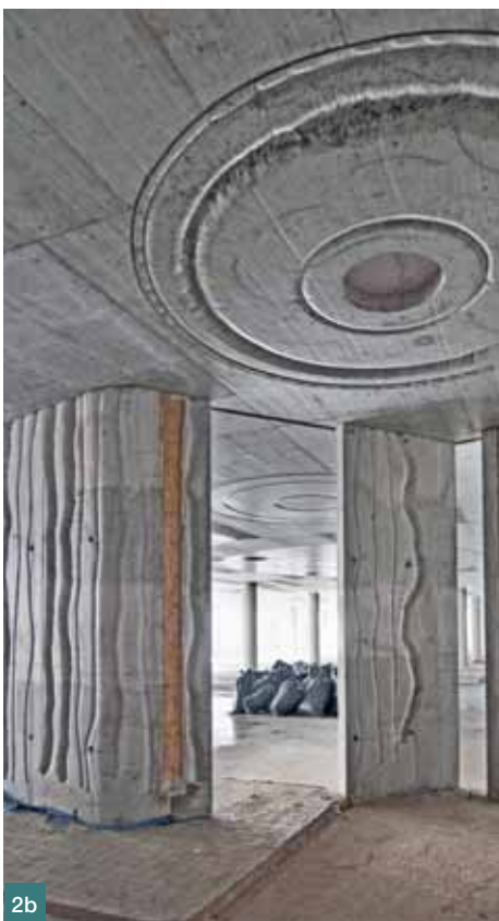
Obr. 2a,b Na stropěch je možné najít i kruhové otisky tvořené lany a kabely ■ Fig. 2a,b Circular prints of ropes and cables can be found on the ceilings
