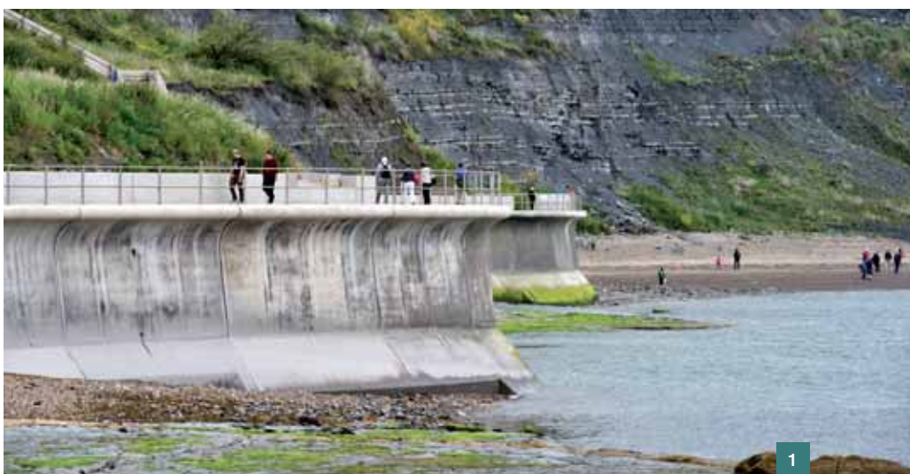
Obr. 1 Dokončená přílivová hráz během odlivu ■ Fig. 1 Completed sea wave return wall during low tide
