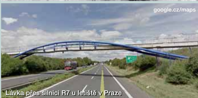
Most Sedlice na dálnici D1 Praha-Brno
