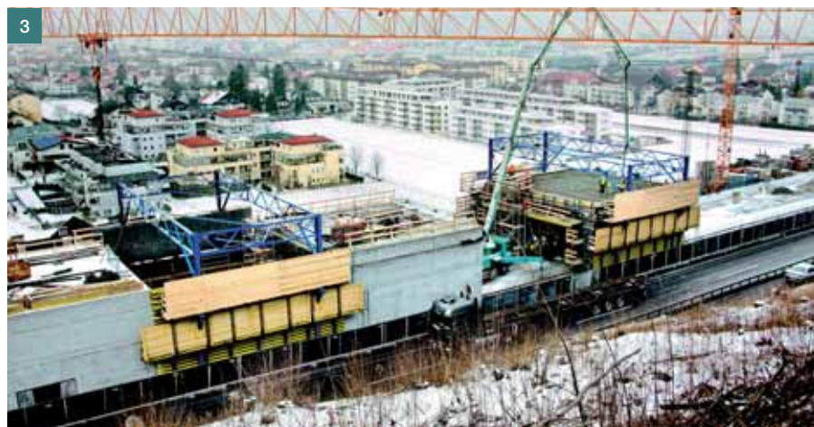
Obr. 3 Betonáž segmentů tunelu v suchých docích, jednotlivé segmenty jsou následně přepravovány lodí a usazeny pomocí plovoucích jeřábů Fig. 3 Concreting the tunnel segments in dry docks, the individual segments being then towed down to the project site and immersed by floating cranes
