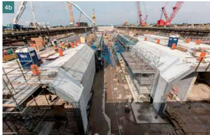
Obr. 4a,b Příprava vjezdových a výjezdových portálů tunelu na obou stranách řeky Elizabeth, portály jsou betonovány stejným systémem jako segmenty tunelu Fig. 4a,b Preparation of the entrance and leaving portals of the tunnel on both sides of the Elizabeth River, the portals are concreted same way as the tunnel segments
