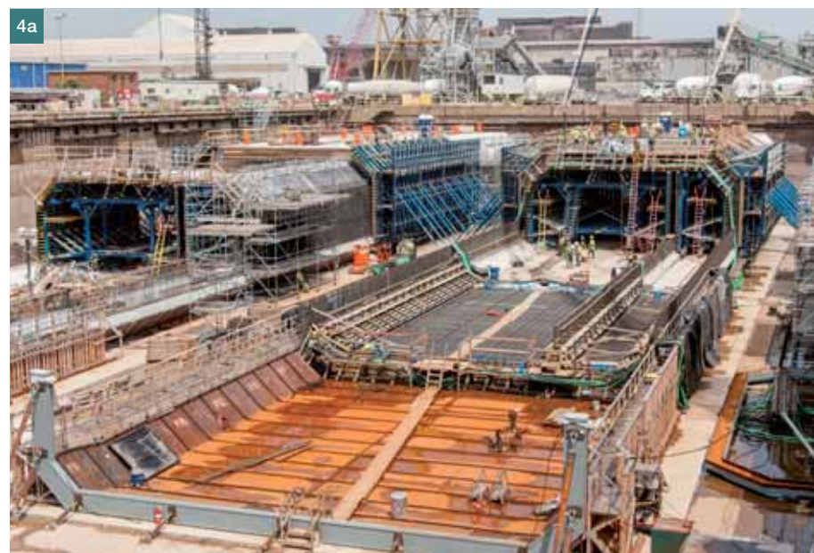
Obr. 4a,b Příprava vjezdových a výjezdových portálů tunelu na obou stranách řeky Elizabeth, portály jsou betonovány stejným systémem jako segmenty tunelu Fig. 4a,b Preparation of the entrance and leaving portals of the tunnel on both sides of the Elizabeth River, the portals are concreted same way as the tunnel segments
