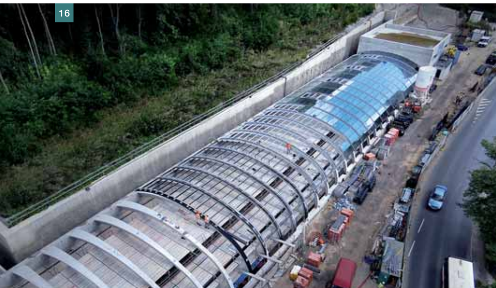
Obr. 16 Nemocnice Motol: montáž proskleného střešního pláště stanice, 2013
