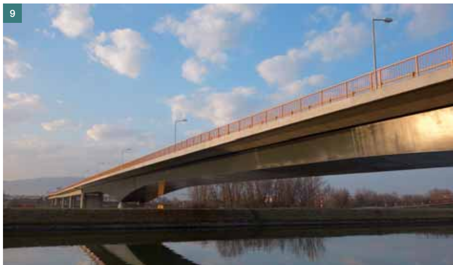
Obr. 9 Dokončená konstrukce mostu ■ Fig. 9 Finished construction of the bridge
