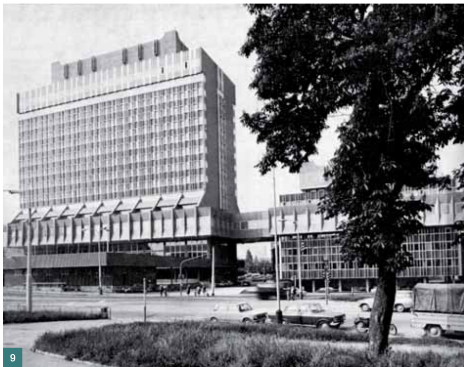
Obr. 9 Podnik zahraničního obchodu Centrotex v Praze, Václav Hlinský, Otakar Jurenka, 1972 až 1978 (Architektura ČSR, 1979) ■ Fig. 9 International trading enterprises Centrotex in Prague, Václav Hlinský, Otakar Jurenka, 1972–1978 (Architektura ČSR, 1979)
