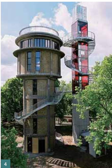
Obr. 3 Originální rodinné bydlení, Soest, Holandsko ■ Fig. 3 Original family residence, Soest, The Netherlands
