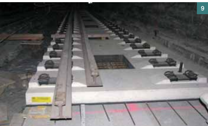
Obr. 9 Zabudované železniční pražce před zalitím SCC ■ Fig. 9 Built-in railway sleepers before casting SCC
